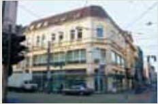
Wohn- und Geschäftshaus in Duisburg
